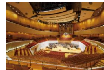
舞台照明システム
