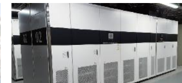
受変電システム (UPS)
